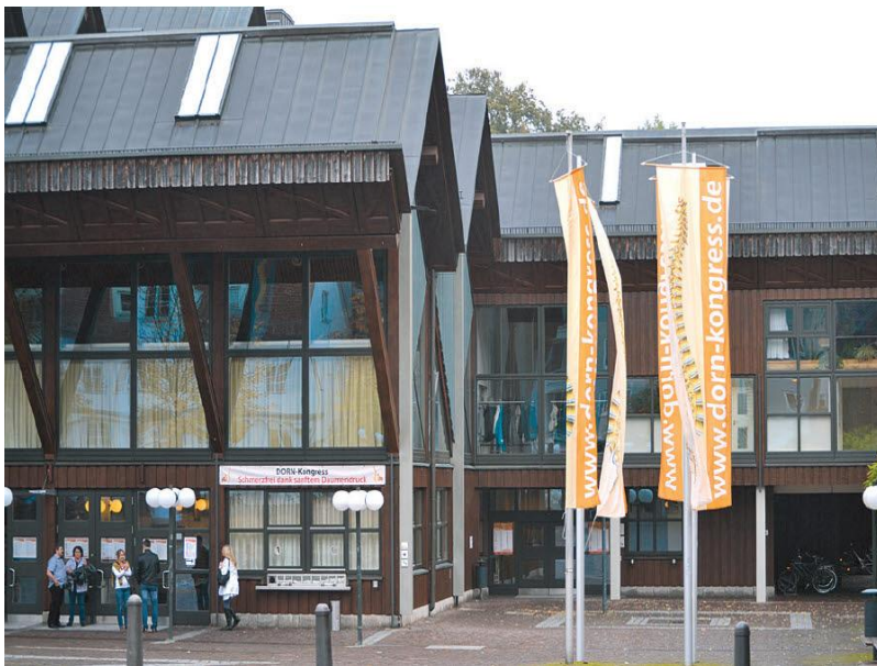
Vorplatz der Stadthalle Memmingen
